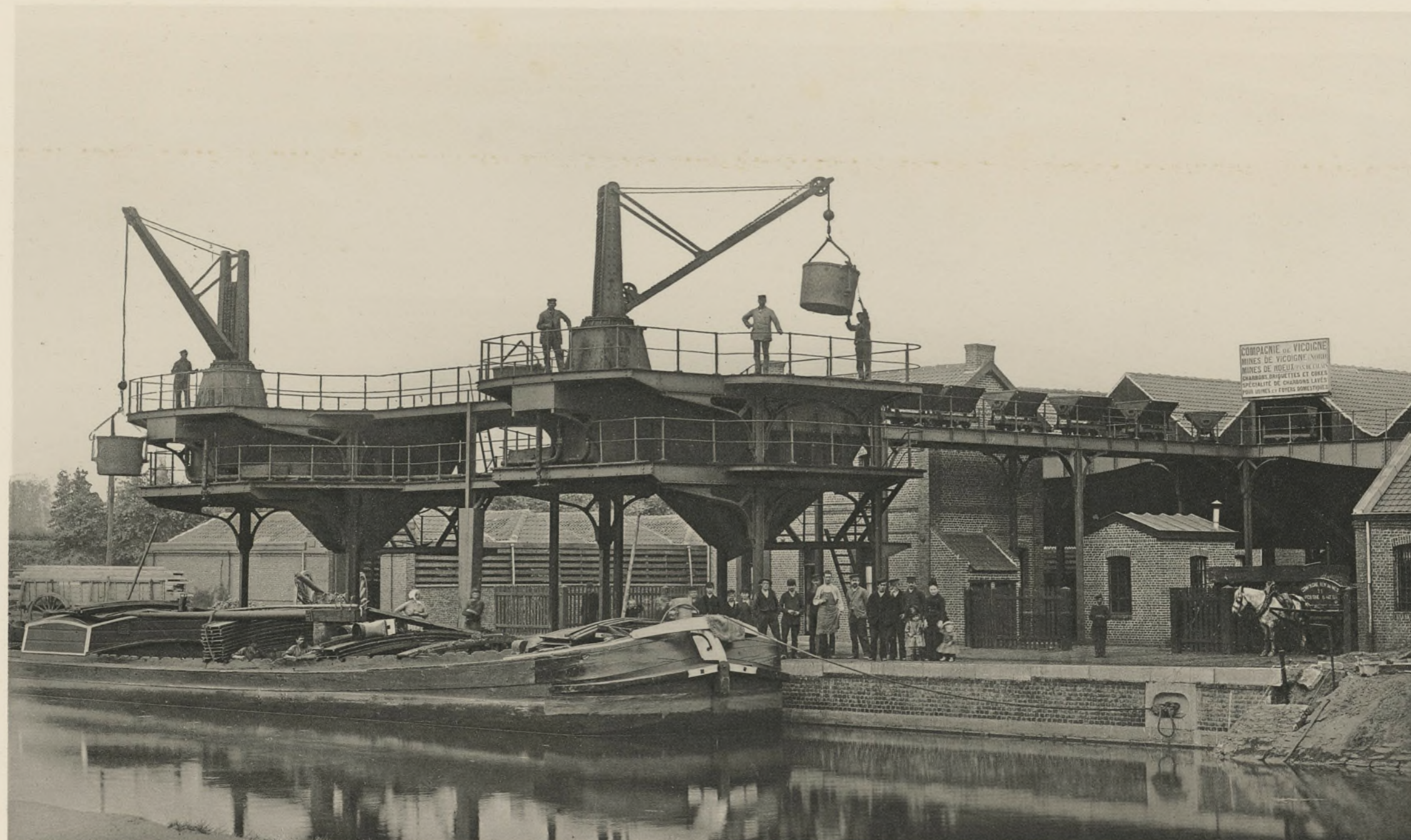
DÉBARCADÈRE AVEC GRUES HYDRAULIQUES Pour le déchargement des charbons Etabli à Roubaix pour la Compagnie des Mines de Nœux
