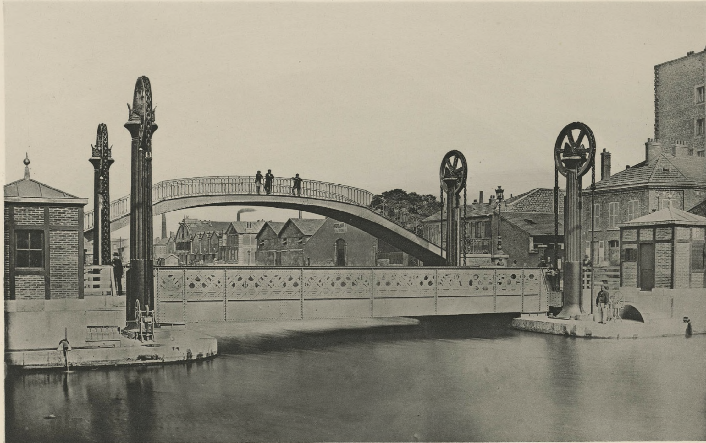
PONT LEVANT À SOULÈVEMENT PARALLÈLE MÛ PAR L'EAU SOUS-PRESSION SYSTÈME BRÉVETÉ S.G.D.G.
