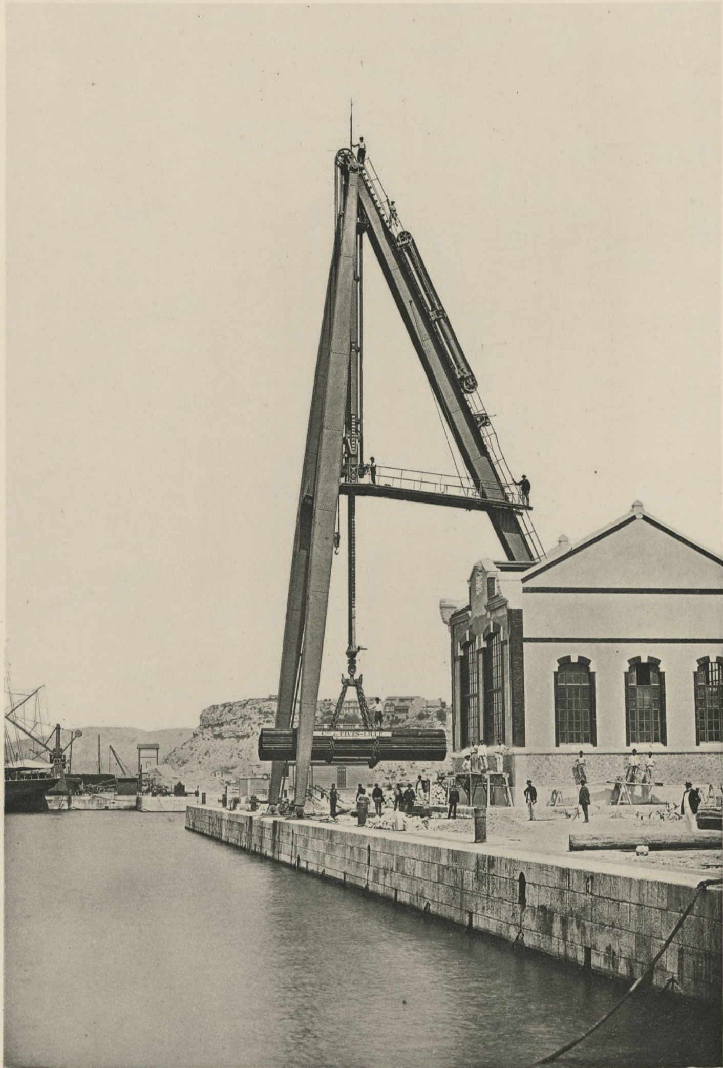
BIGUE HYDRAULIQUE À TRIPLE PUISSANCE DE 25.75 ET 120 T Port de Marseille - Outillage hydraulique de la Chambre de Commerce
