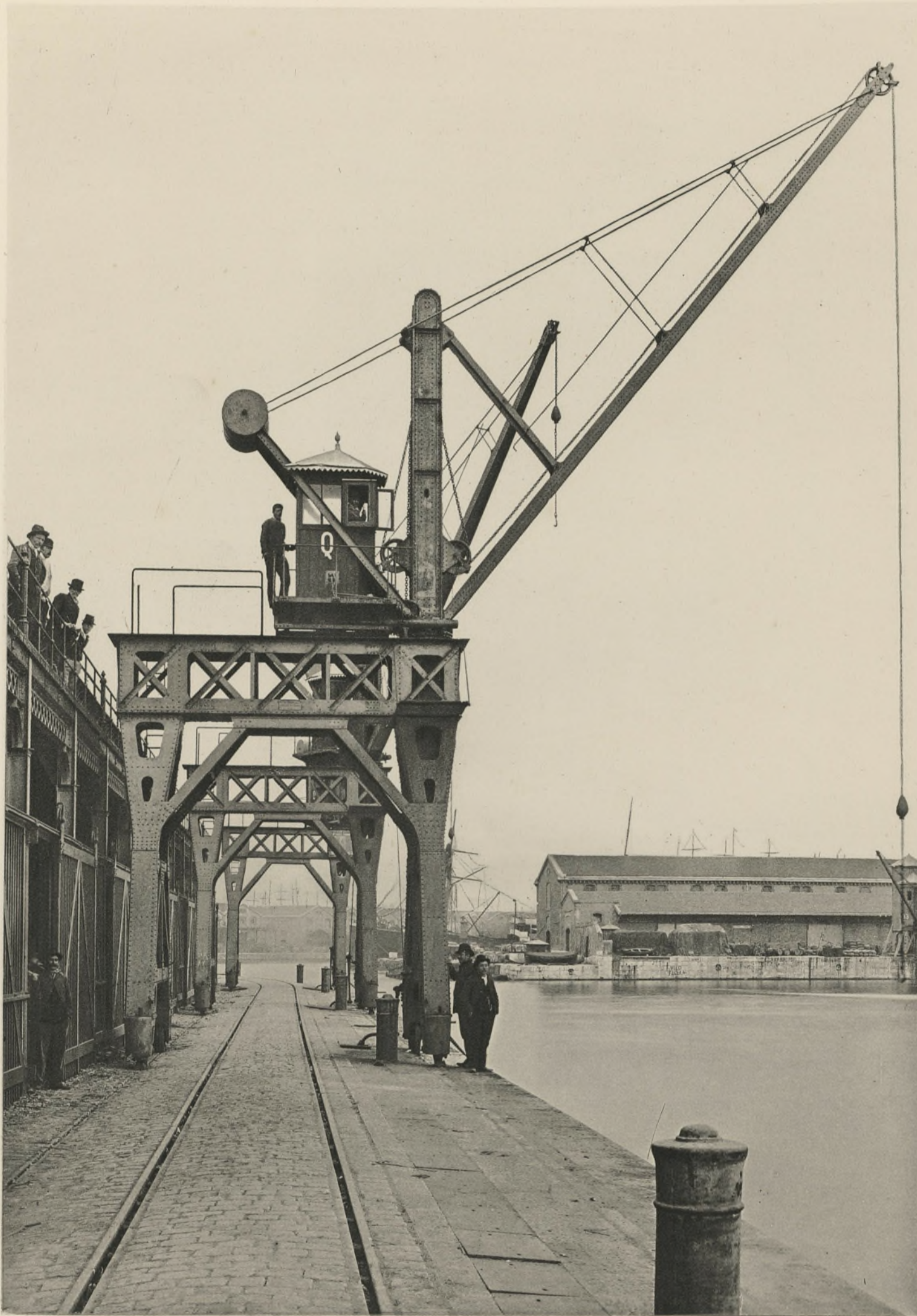
GRUE HYDRAULIQUE MOBILE POUVANT ENLEVER 1250 K OS Port de Marseille - Outillage hydraulique de la C ie des Docks et Entrepôts
