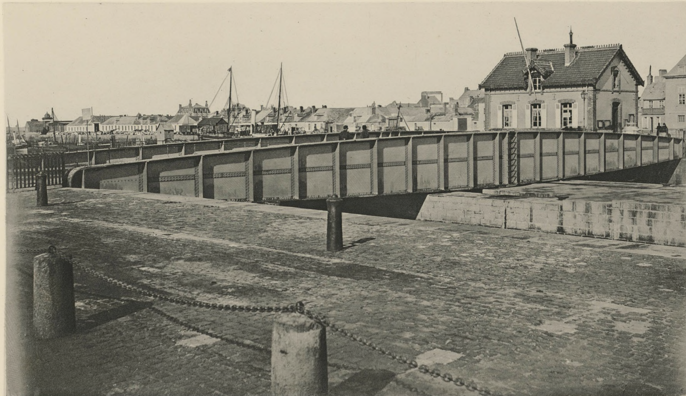
PONT TOURNANT À SOULÈVEMENT DROIT À MANŒUVRES HYDRAULIQUES Etabli sur les écluses du Commerce de Cherbourg
