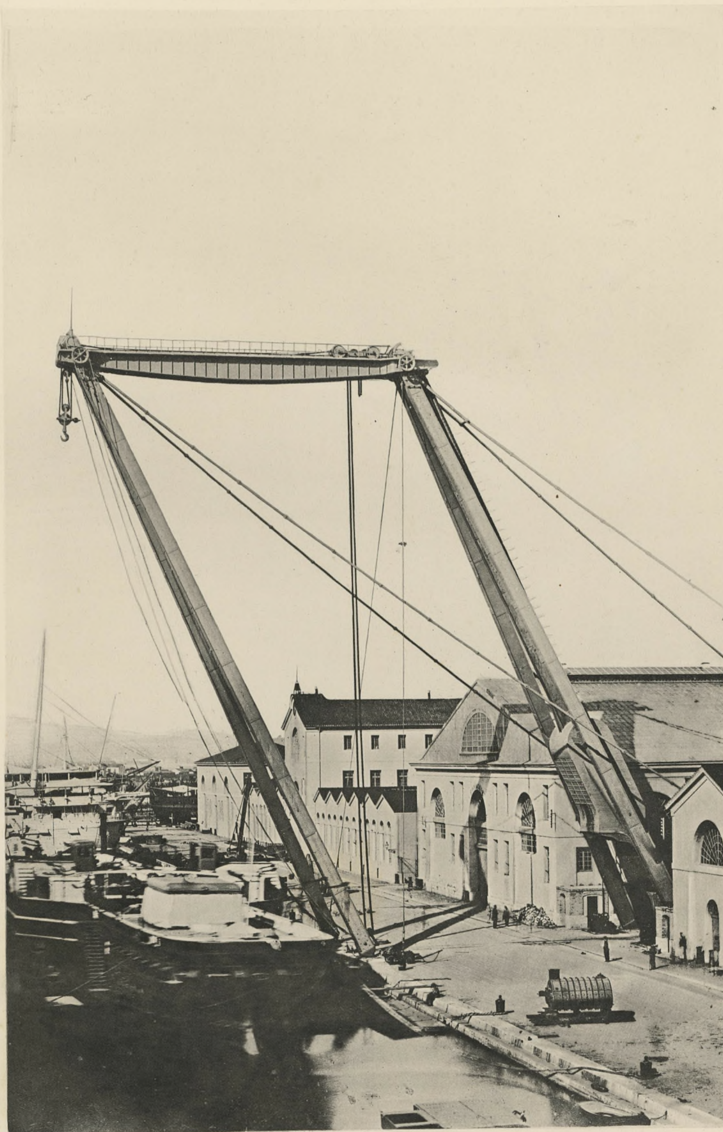
GRAND APPAREIL DE TRANSBORDEMENT ET DE MÂTAGE (SYSTÈME NEUSTADT)
