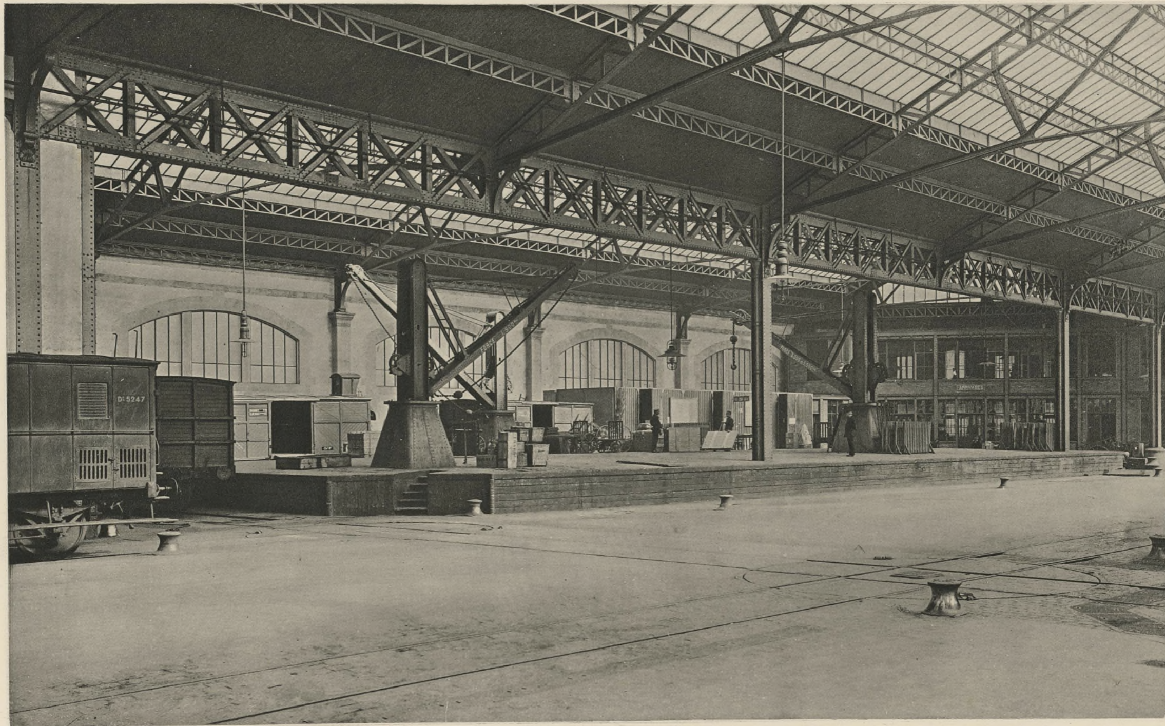
Outillage hydraulique de la Gare des Messageries de St-Lazare à Paris VUE GÉNÉRALE DE LA GARE SUPÉRIEURE
