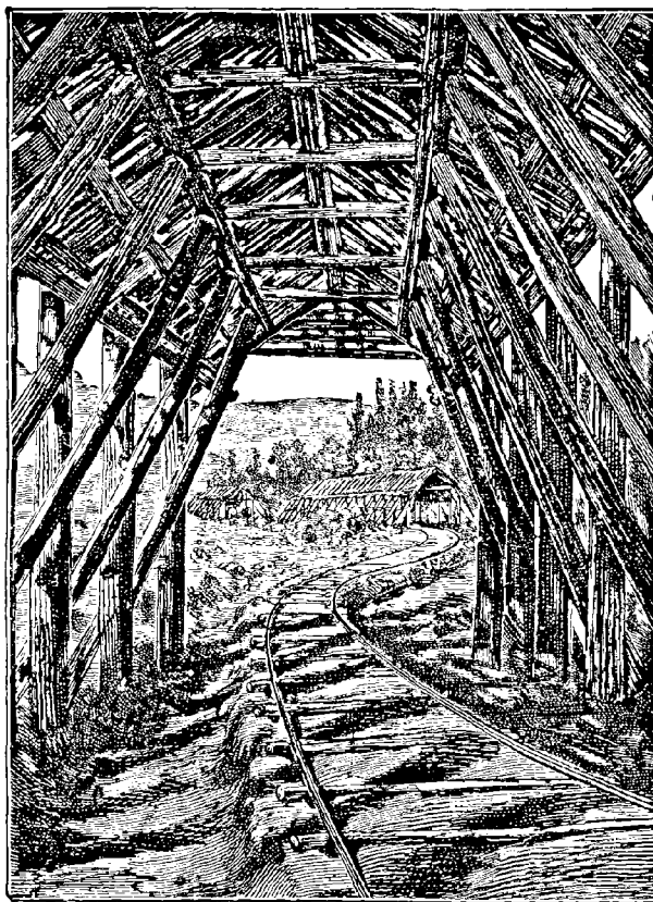
Fig. 370. — Abri contre la neige, vue intérieure.
