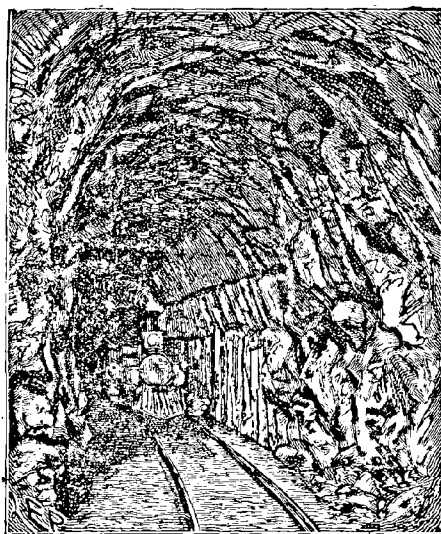
Fig. 365. — Tunnel du Hoosac.
