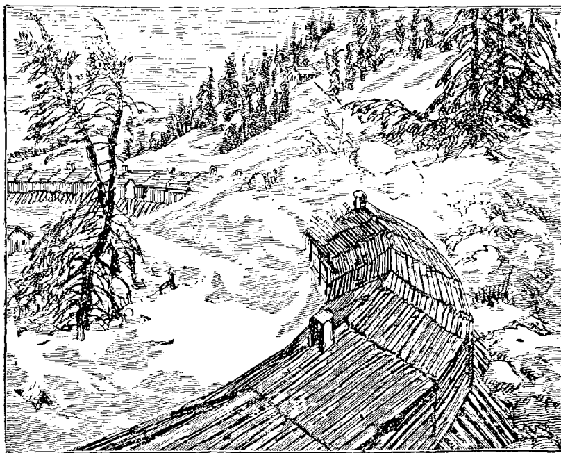
Fig. 371. — Abri contre les avalanches, sur le chemin de fer du Pacifique, dans la Sierra Nevada.
