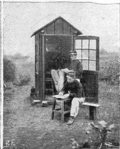
LA CABINE TÉLÉPHONIQUE. — Elle supprime l'inconvénient des lourdes voitures du train; on peut ainsi multiplier les postes. A l'intérieur, un appareil est installé; il n'y a plus qu'à réunir les fils
