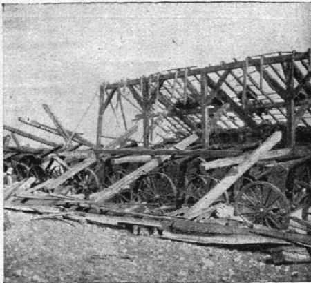
EXPLOSION D'UNE POUDRIÈRE. — La poudrière du fort de Montfaucon, près de Besançon, a fait explosion le 16 septembre. Deux militaires et cinq civils ont été tués. Causes probables de l'accident : la foudre. L'hypothèse de la malveillance a, cependant, été examinée par les enquêteurs.
