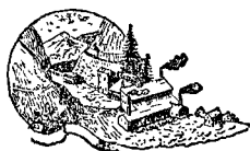
Fig. 491. — Ensemble d'une usine d'amalgamation d'après le procédé de Reese-River (Granite-Montain-Mill) ; vue extérieure.
