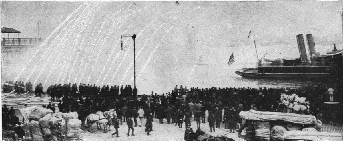
CONCOURS DE POMPES FLUVIALES. — Un service spécial a été organisé à Chicago pour lutter contre les incendies qui n'éclatent que trop fréquemment à bord des innombrables navires qui fréquentent ce grand port. Des bouées permettaient de mesurer la portée des jets, dont les plus puissants dépassèrent un but éloigné de cent dix mètres. Voilà des expériences que l'on devrait bien tenter dans les grandes villes de France.
