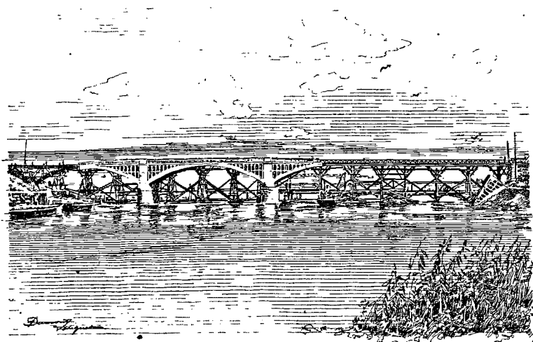
Fig. 208. — Vue du pont de Bezons, sur la Seine, après sa destruction. Vue du pont provisoire en bois.
