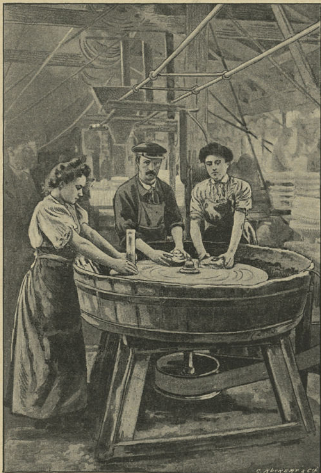
Retouche des pièces à la meule. Document pris aux Cristalleries de Pantin, par A. Collombar.)
