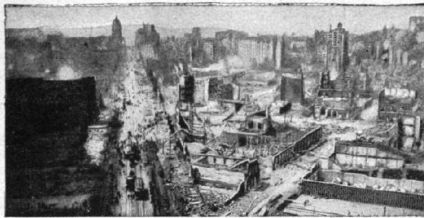
La rue principale de San Francisco avec les travaux de reconstruction. Cette vue a été prise le 5 juin. On remarquera que les tramways recommencent à circuler.
