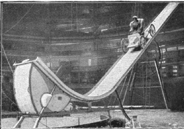
LE CERCLE DE LA MORT. — En modifiant à volonté au moyen de poulies le mouvement d'une automobile qui boucle le cercle de la mort, on a pu déterminer le point précis, que montre notre photographie, où la voiture donne son maximum de vitesse avant d'accomplir le saut dans le vide.
