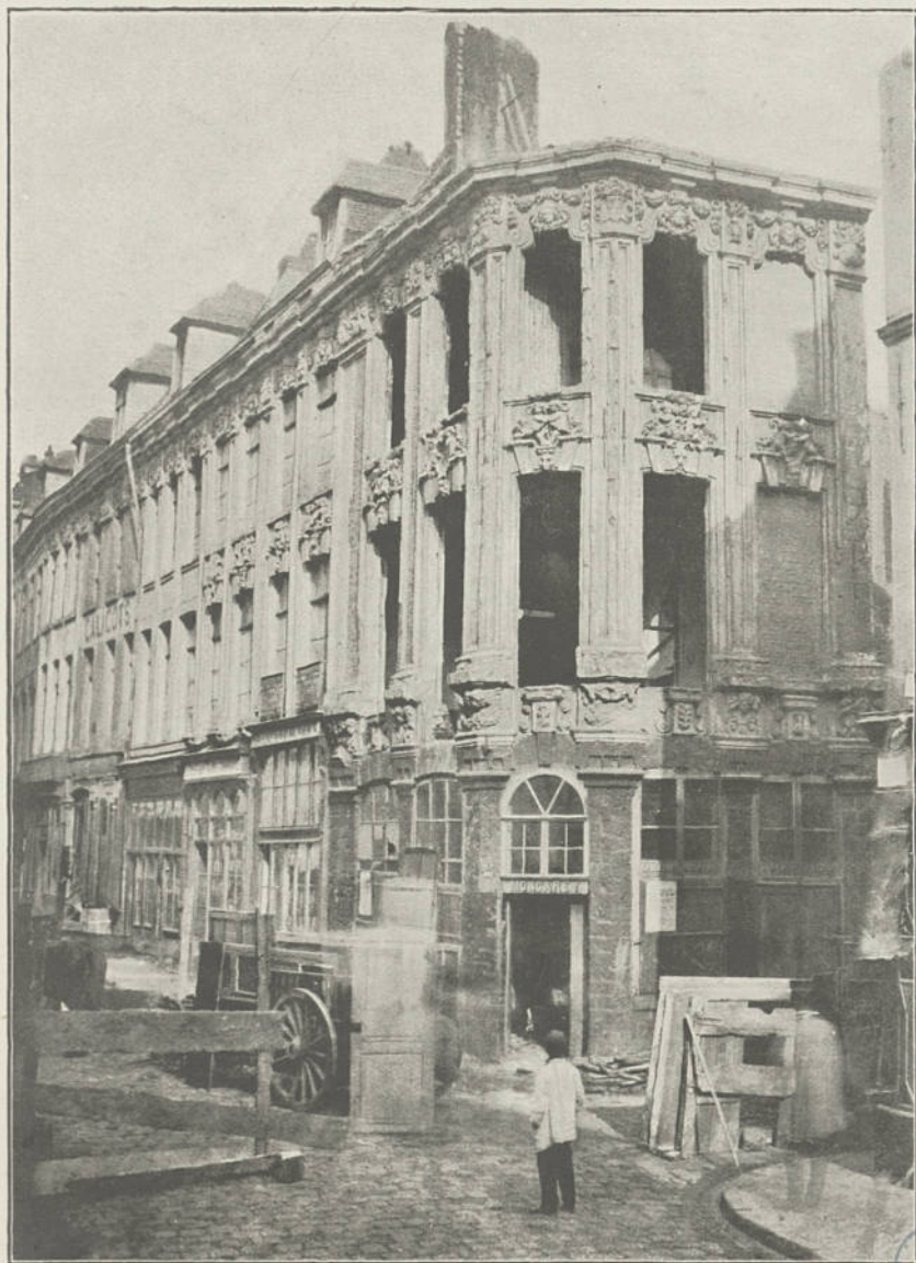
Pl. IV. — Maison démolie, à l'angle des rues des Arts et de Roubaix, bâtie par Michel Rougé en 1684.
