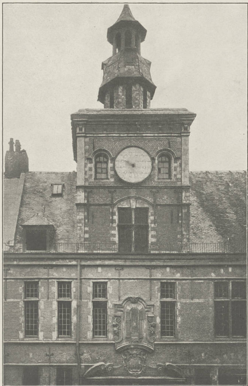
Pl. X. — Premier étage de la façade sur cour de l'Hospice Comtesse (fronton, niche et tour).
