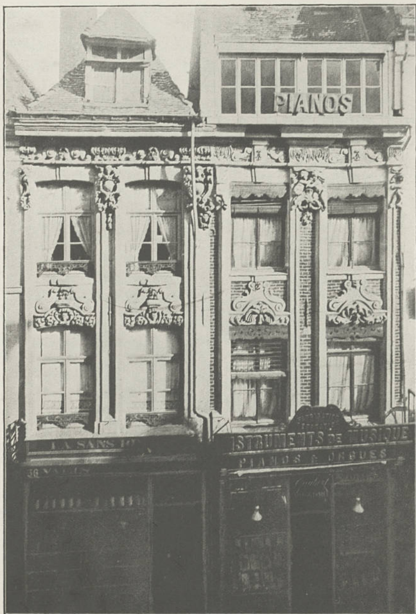
Pl. XLII. — Maisons de la rue Esquermoise, 34, 36. (A droite, type du « Porc d'Or » Grand'Place; A gauche, type du Beau-Regard).
