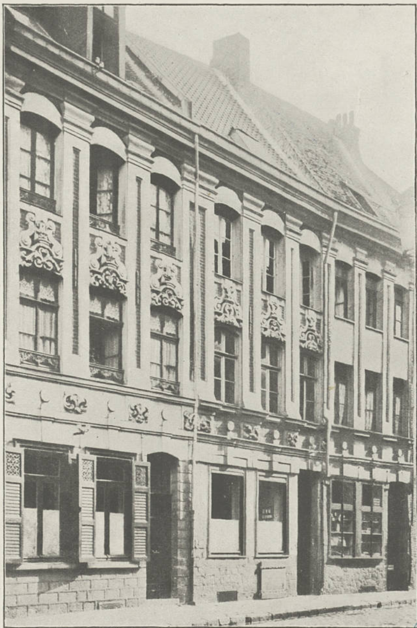
Pl. XLI. — Façades de la Terrasse Ste-Catherine.
