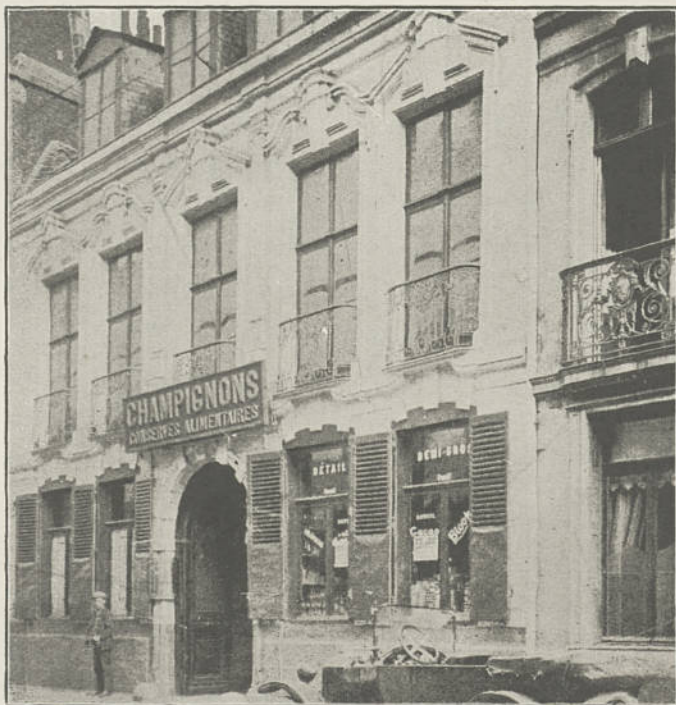
Pl. XVII. — 2. Façade du N° 45 de la rue Basse (1651).
