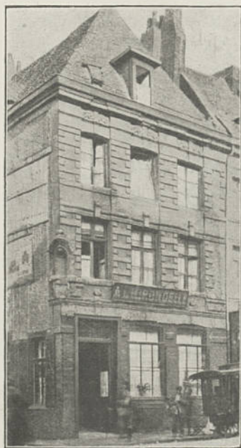
3. Façade, rue de Paris, 209 (1682).
