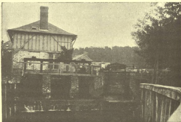
FIG. 111. — Barrage de l'usine hydro-électrique de Montfort, sur la Rille (Eure); à droite, vanne régulatrice.
