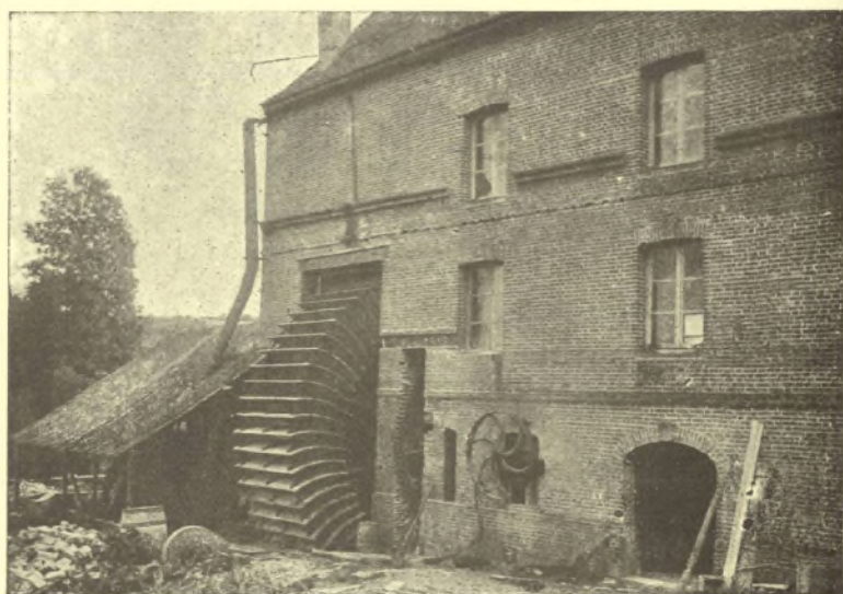
FIG. 38. — La roue Sagebien du moulin de Quincampoix, sur la Rille, en réparation (Eure).
