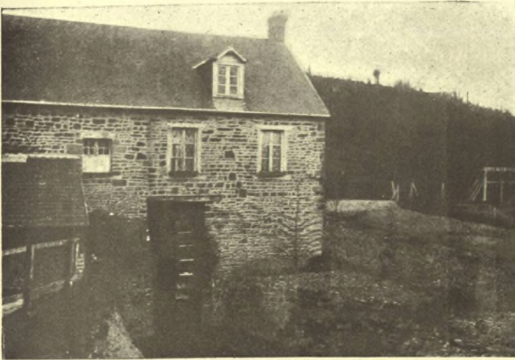
FIG. 39. — Ancienne roue à palettes, sur la Vire canalisée à Tessy (Manche).
