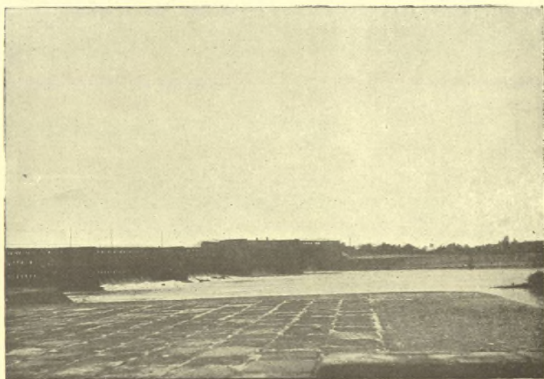
FIG. 118. — Le barrage de Poses, sur la Seine, près d'Amfreville (Eure).
