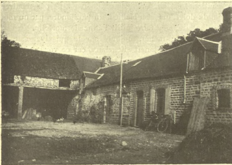
FIG. 95. — Sortie de poste de l'usine de Ducey (Manche).
