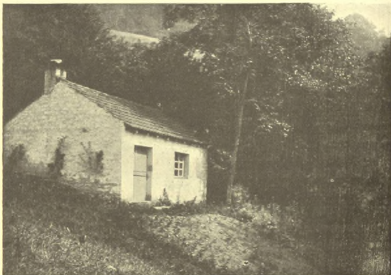
FIG. 28. — Un atelier d'amateur. — Usine hydro-électrique sur la route des Feuillées au Val d'Ajol (Vosges).
