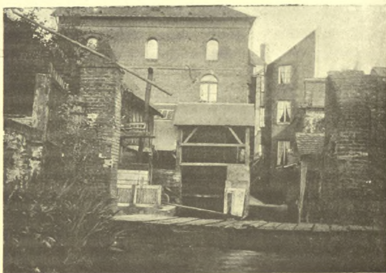
FIG. 112. — Usine hydro-électrique de Cormeilles (Eure). Exemple de roues à palettes.
