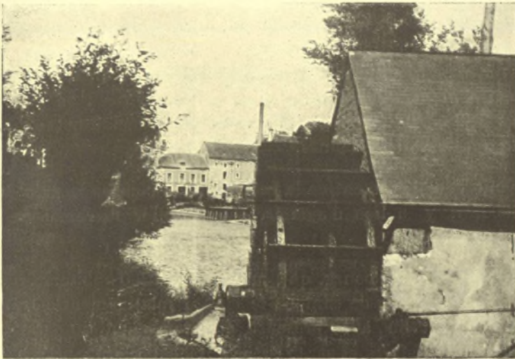
FIG. 80. — Roue de l'usine hydro-électrique de Vaas, sur le Loir navigable (Sarthe).
