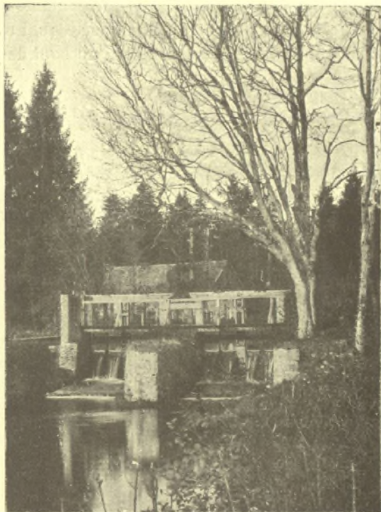
FIG. 40. — Vannes coupées formant déversoir pour niveau abaissé provisoirement [les Masselins, à Chandai (Orne)].
