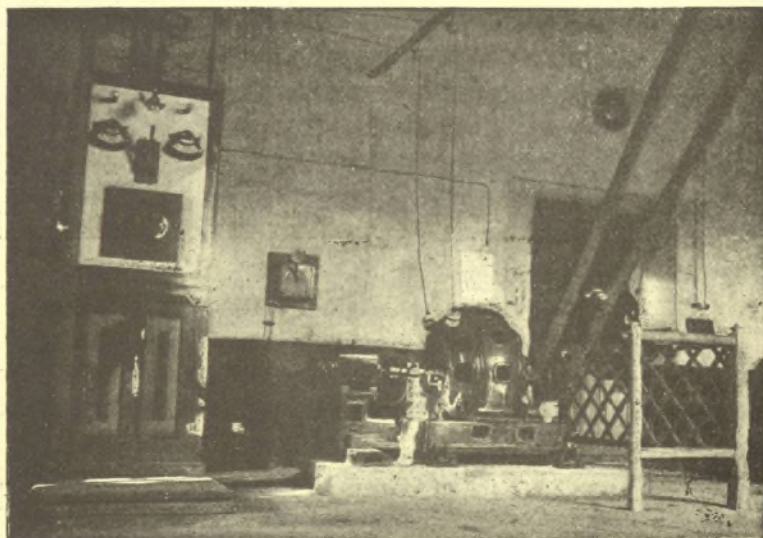
FIG. 105. — L'alternateur produisant le courant à 5.000 volts pour Aunay-sur-Odon, à 14 kilomètres de l'usine de Thury-Harcourt (Calvados).
