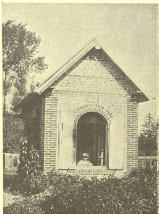
FIG. 64. — Le pavillon hydro-électrique des Masselins, à Chandai (Orne) (Voir aussi figure 4).
