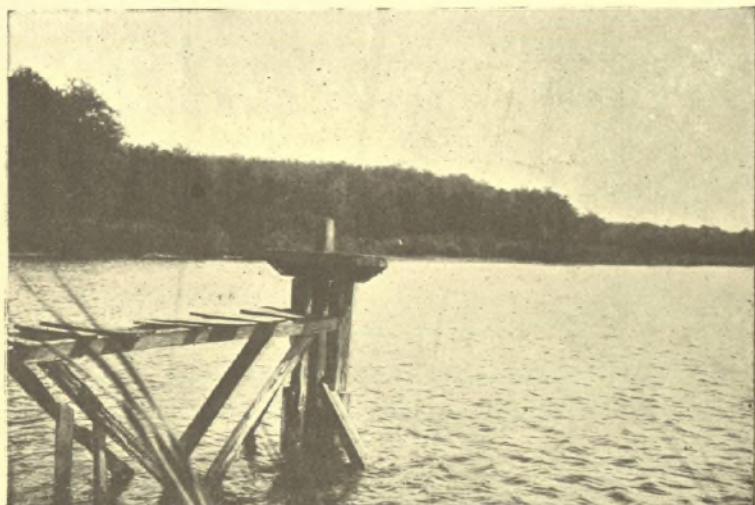
FIG. 15. — L'étang de la Grande-Trappe, régulateur des débits de l'Iton à ses sources.
