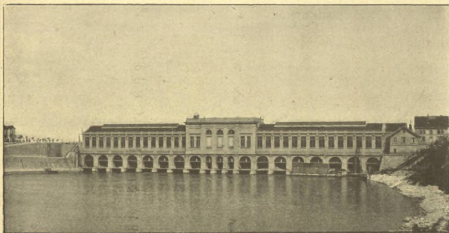
VUE D'ENSEMBLE DE L'USINE DE CUSSET — COTÉ AVAL
