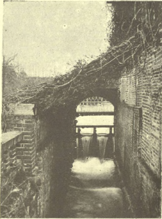
FIG. 45. — Un des deux coursiers de l'ancienne Tréfilerie de Chandai, inutilisé (chute de 1 m ,65).
