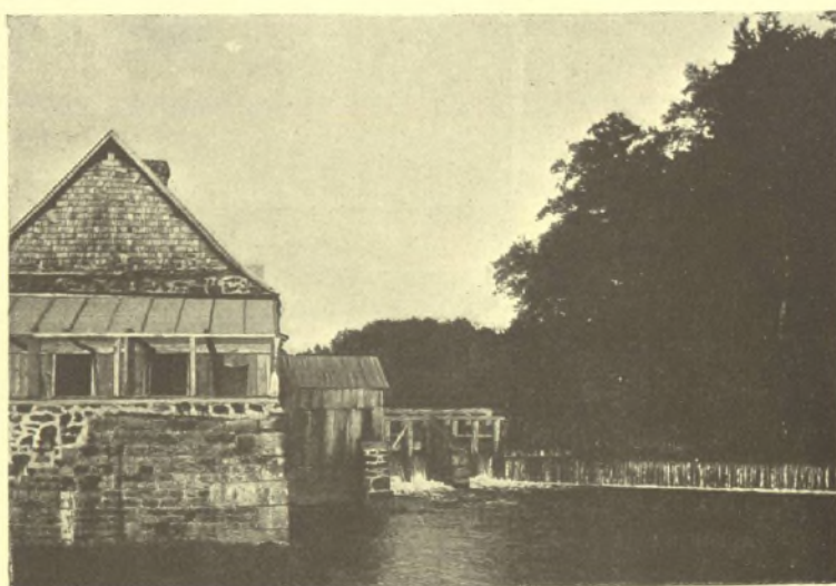
FIG. 94. — L'usine hydro-électrique de Ducey; chute, sur la Selune, de 1 m ,50 (Manche).
