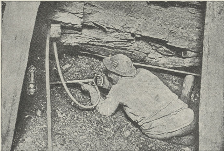
Figure 2. — Emploi du marteau pneumatique.
