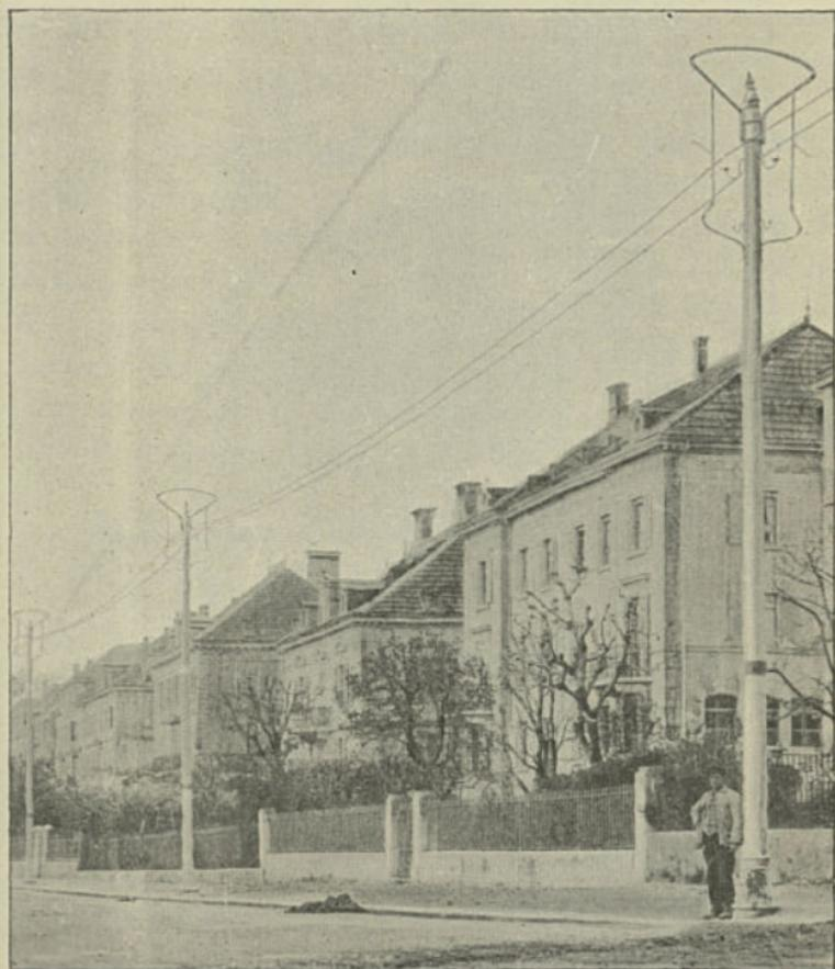
Fig. 48. — Vue d'une canalisation aérienne à courant continu et à haute tension.
