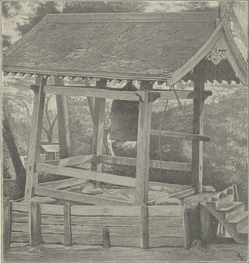
Fig. 202. — Edicule de la cloche du temple d'Anjôji (Sakata) enlevé de ses supports lors du tremblement de terre du Shônai du 22 octobre 1894 (d'après Omori).
