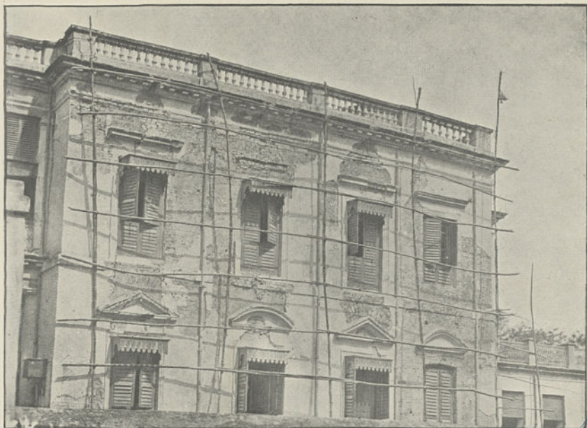
FIG. 179. — CHUTE DU CRÉPIS DE LA FAÇADE D'UNE MAISON DE CALCUTTA, LE 12 JUIN 1897 (d'après R. D. OLDHAM).
