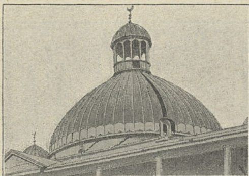
Fig. 189. — Fente à la coupole de la mosquée Djouma à Chémakha lors du tremblement de terre du 31 janvier 1902 (d'après Weber).
