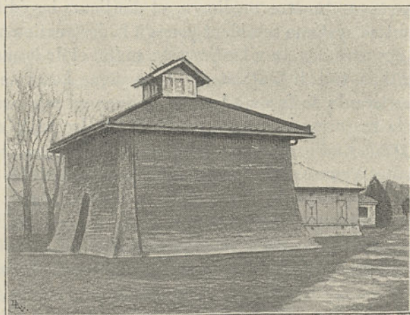
Fig. 197. — Observatoire à murs paraboliques et à toiture libre. Type de Tatsuno.
