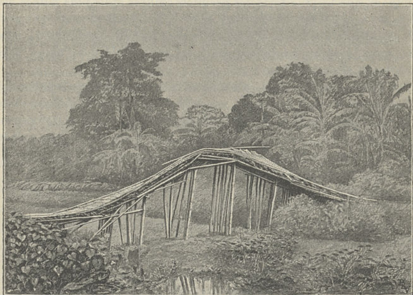
Fig. 163. — Pont aux environs de Rangpur, bombé par le tremblement de terre de l'Assam du 12 juin 1897 (d'après R. D. Oldham).
