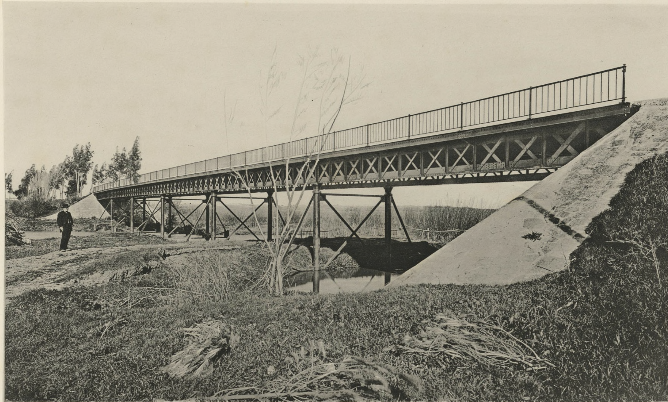
PONT-ROUTE DE PONTINHA ( PORTUGAL ) Route districale n° 76 de Benavente à Tramagal Tablier établi sur colonnes en fonte vissées
