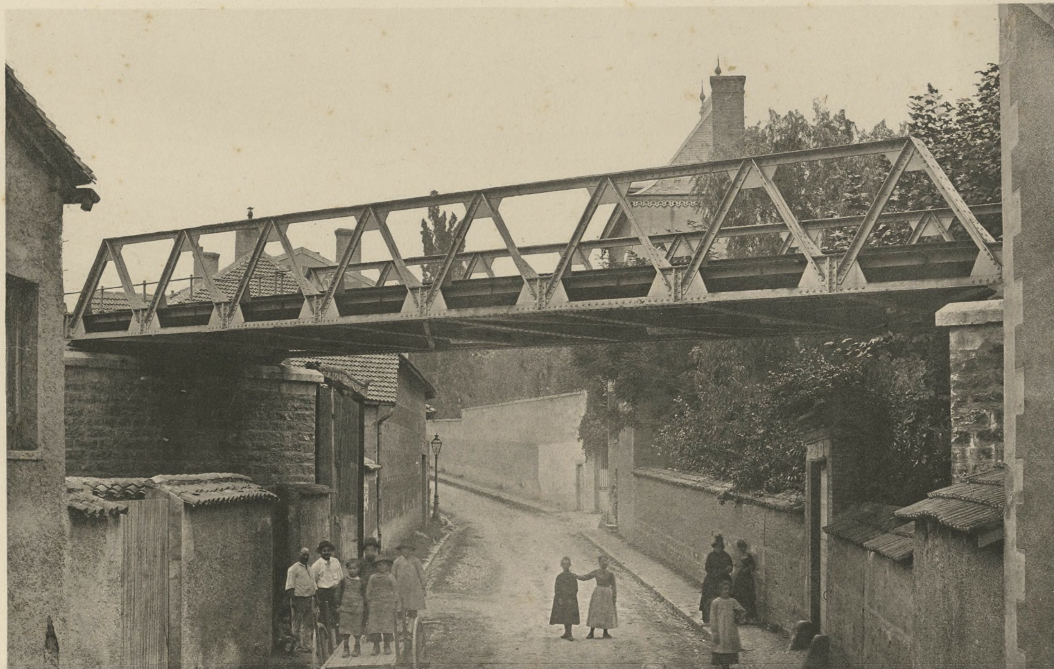
PONT À POUTRES SPÉCIALES DE 15 m 00 DE PORTÉE SUR LA ROUTE DE LA GARDE
