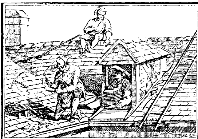
Couvreurs sur un toit, d'après Duplessi-Bertaux.
