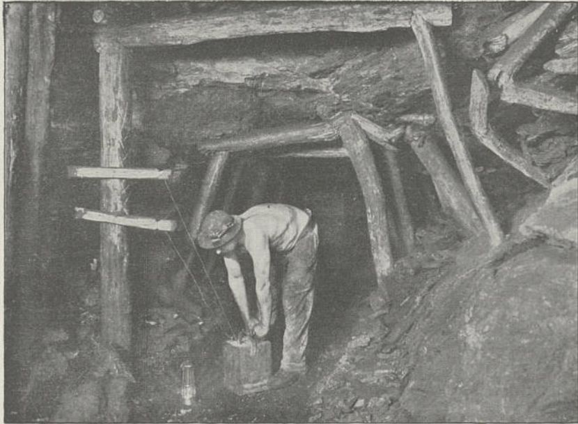
TIR ELECTRIQUE D'UNE MINE
