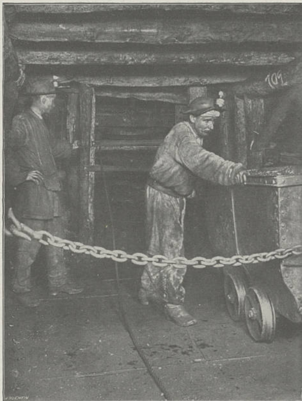
MANGEUVRE D'UNE BERLINE A LA TÊTE D'UN PLAN INCLINÉ
