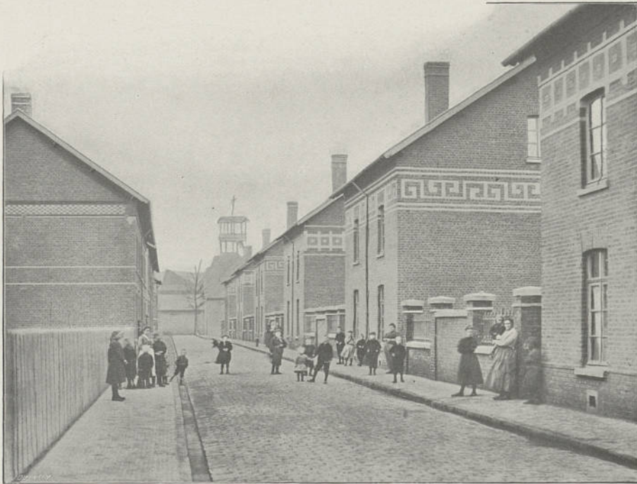
UNE RUE DE LA CITÉ SAINT-ELIE (FOSSE N° 13)
