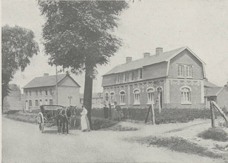
MAISONS DE LA CITÉ SAINT-ÉMILE (FOSSE N° 14)
