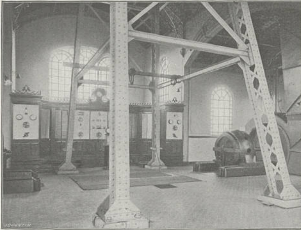
FOSSE D'AÉRAGE N° 11 BIS
