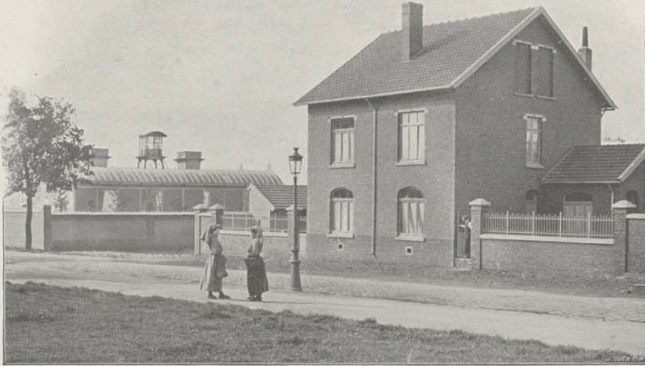
MAISON D'OUVRIER PRÈS DE LA FOSSE N° 12 bis
