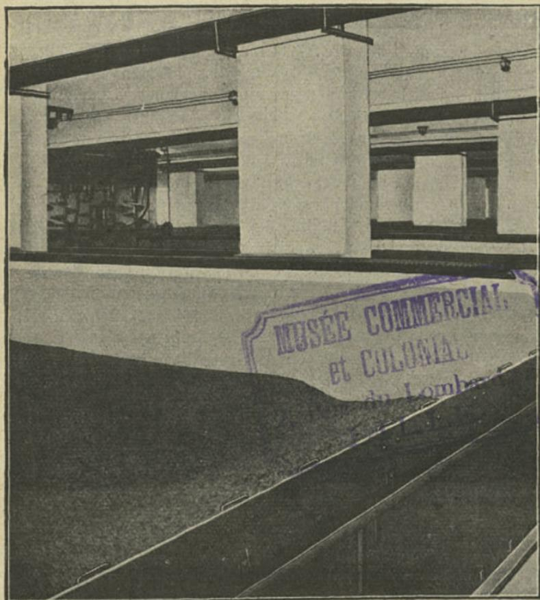
Fig. 49. — Salle de germination Saladin. (Diebold et C<sup>o</sup>, Nancy.)
