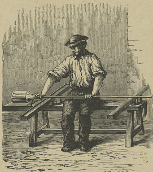
Fabrication d'une carafe.
