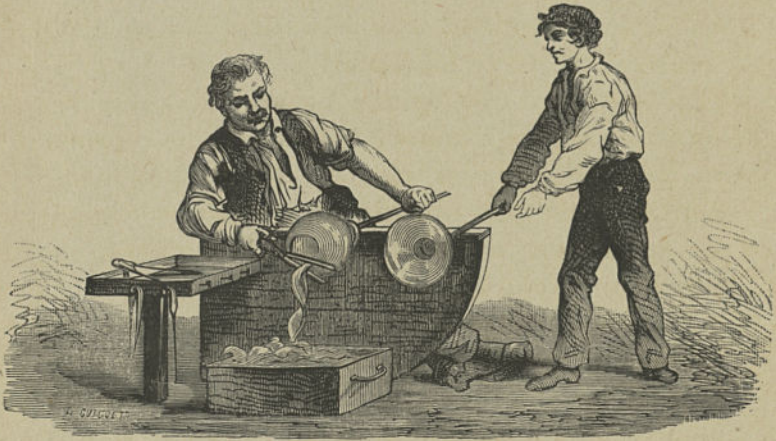
L'ouvrier rogne, avec des ciseaux, la base du verre à pied.
