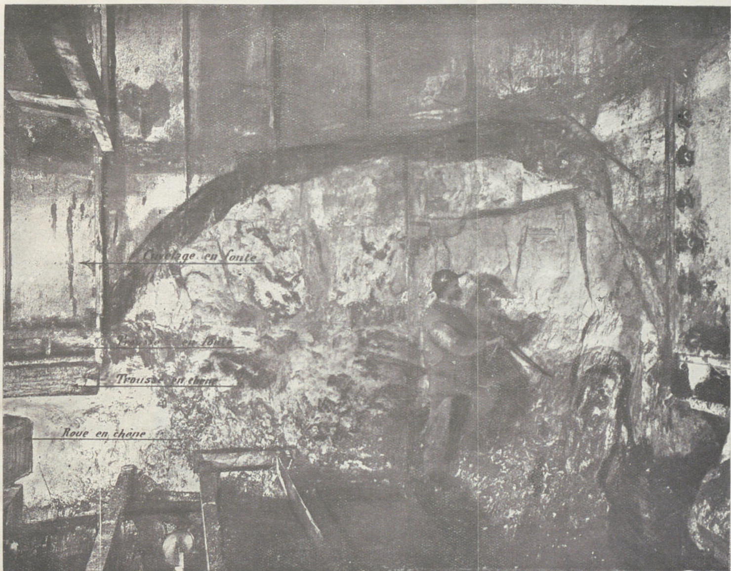
Brèche dans le cuvelage de la fosse 12 de Lens.
