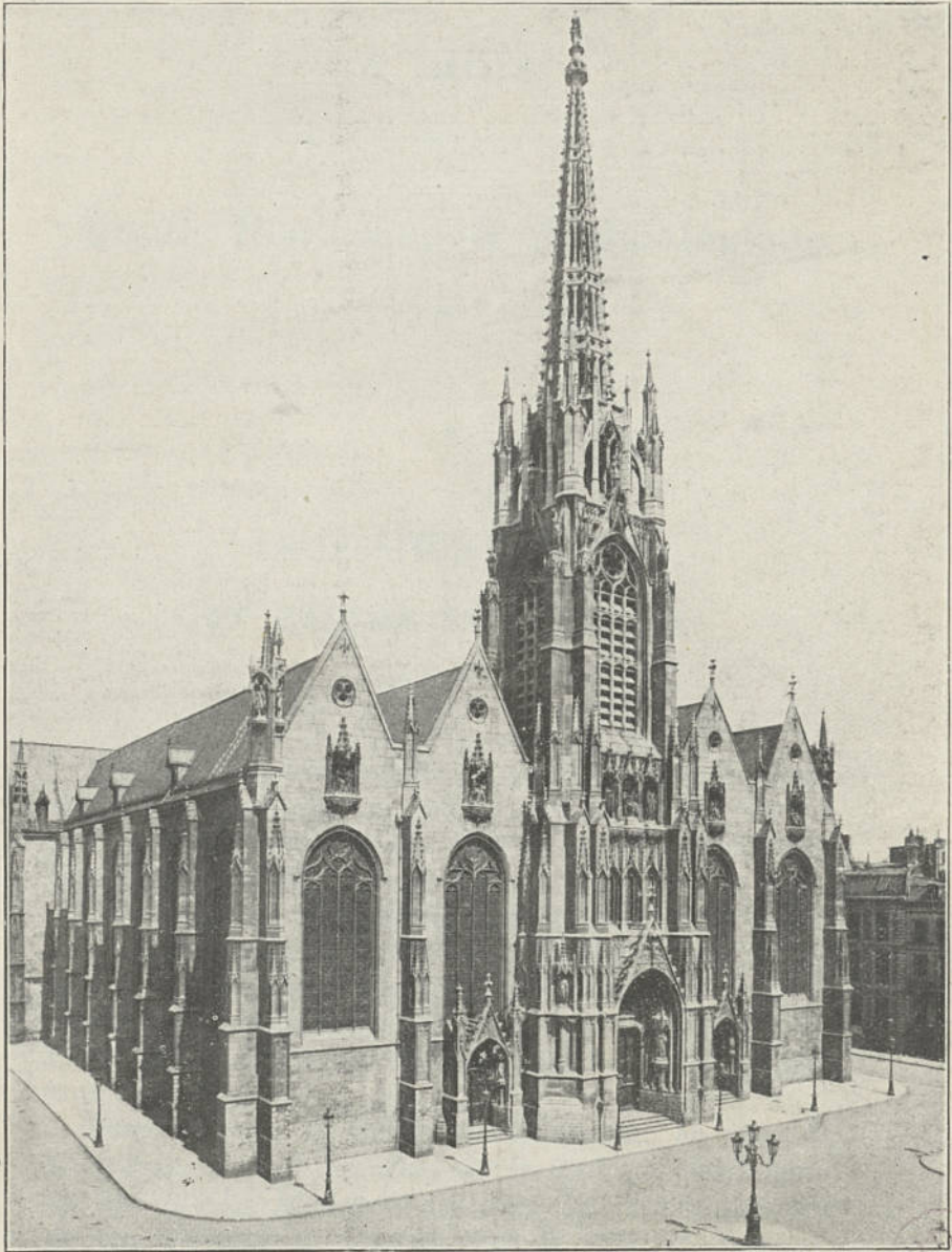
L'ÉGLISE SAINT-MAURICE. — Flèche et façade.
