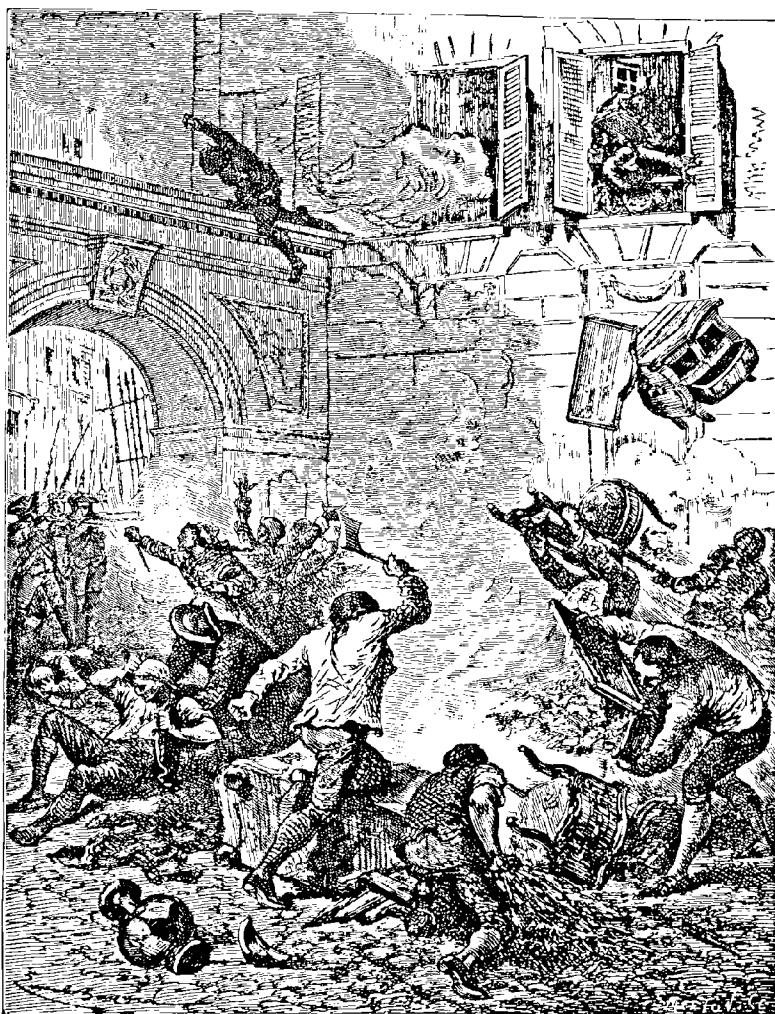
Fig. 130. — Pillage et incendie de la maison de Réveillon, au faubourg Saint-Antoine (page 318).
