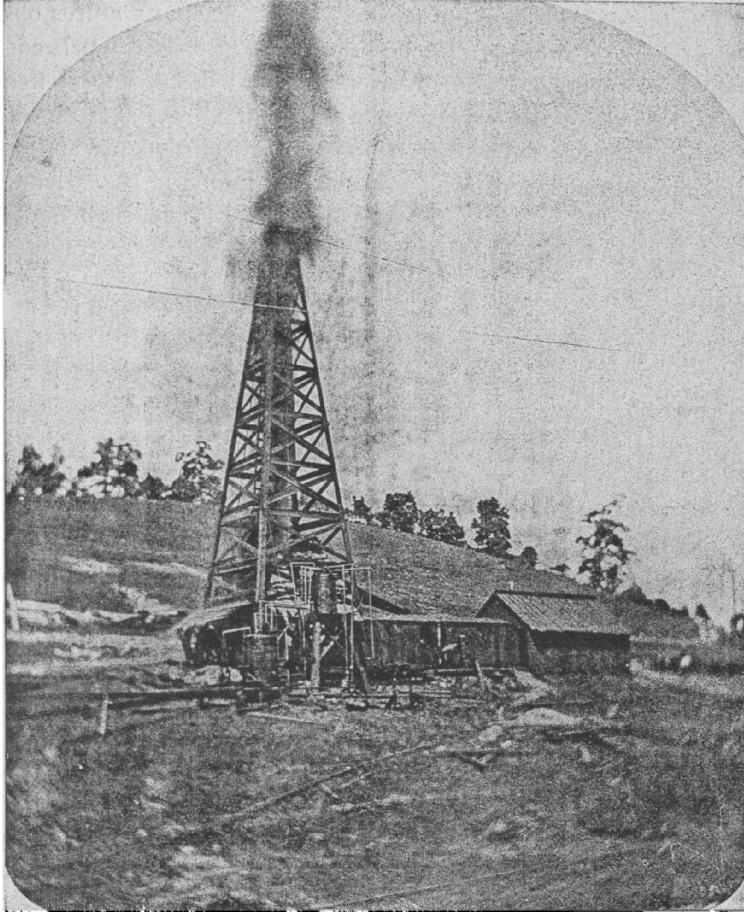
Fig. 11. — Vue d'une fontaine jaillissante.
