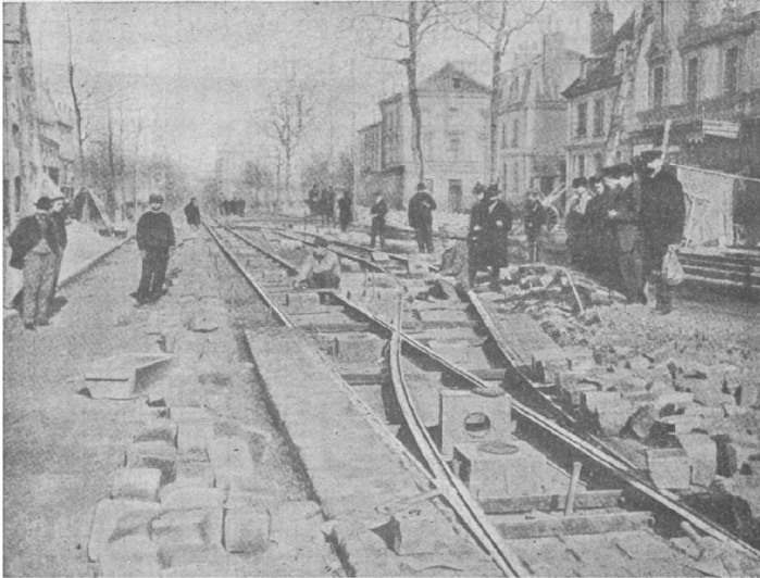
Fig. 122. — Système Diatto. — Pose des plots.
