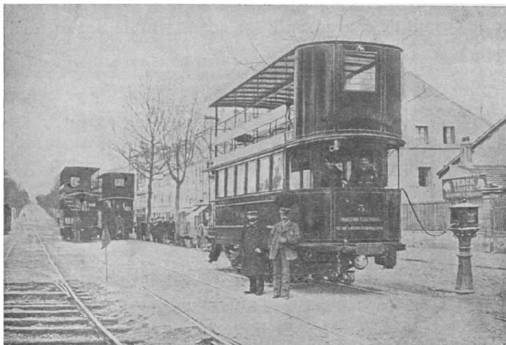
Fig. 128. — Tramways à accumulateurs à charge rapide. Charge au terminus.
