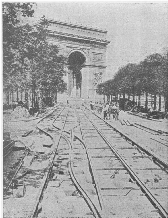
Fig. 92. — Aiguillage avec caniveau axial.
