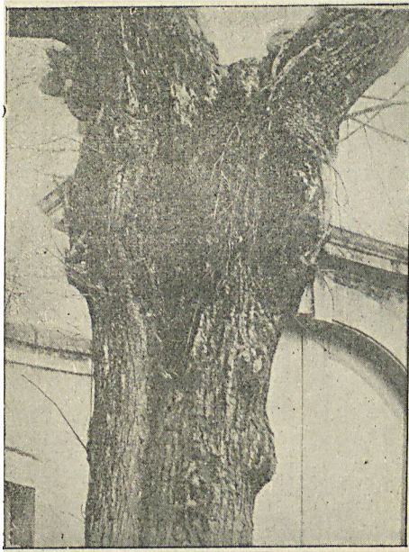
Fig. 411. — Tronc de tilleul dont le cœur est à peu près complètement détruit par la pourriture. Des racines, qui se sont formées aux dépens d'une branche, envoient leurs ramifications dans l'espace d'humus accumulé dans le tronc.
