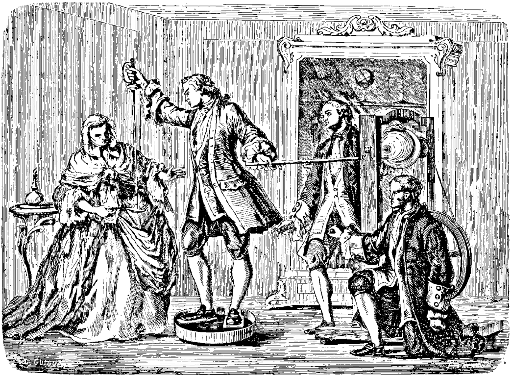
Fig. 238. — Inflammation de l'esprit de vin par une étincelle électrique.
