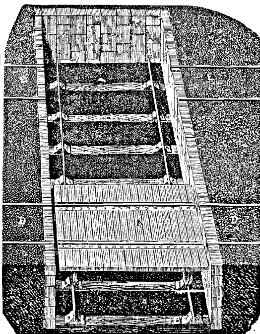
Fig. 190. — Chariot et fossé pour les changements de voie. Nous nous dispenserons de décrire que foule d'autres appareils qu'on a imaginés dans un but analogue.
