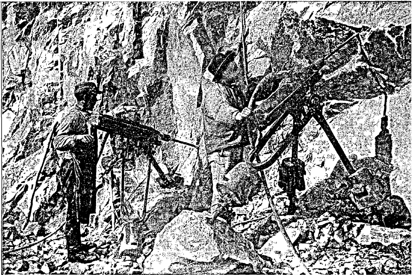
Fig. 203. — Perforatrice électrique à percussion Thomson-Houston, fonctionnant dans une carrière.
