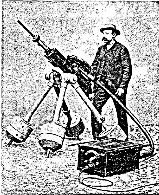
Fig. 207. — Perforatrice électrique à percussion Siemens et Halske.
