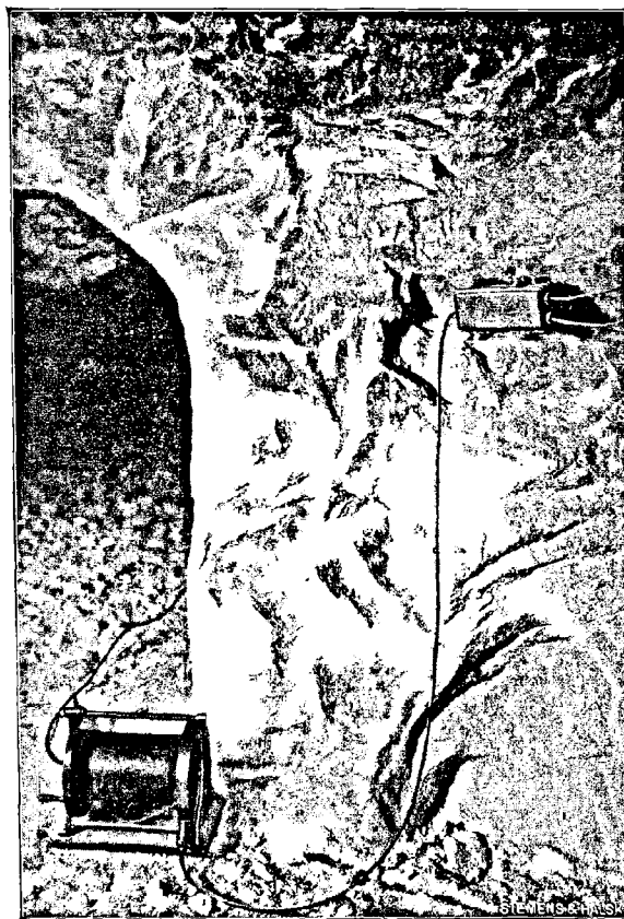
Fig. 145. — Utilisation du câble mobile de jonction dans les mines de sel de New-Stassfurt.
