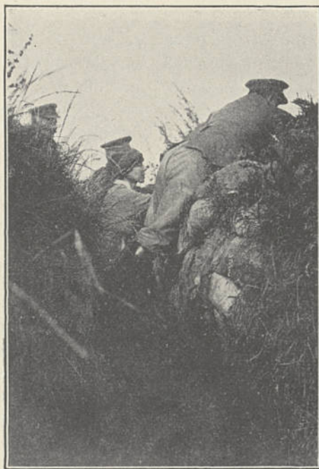
S. M. LA REINE DANS LES TRANCHÉES (JUIN 1915)
