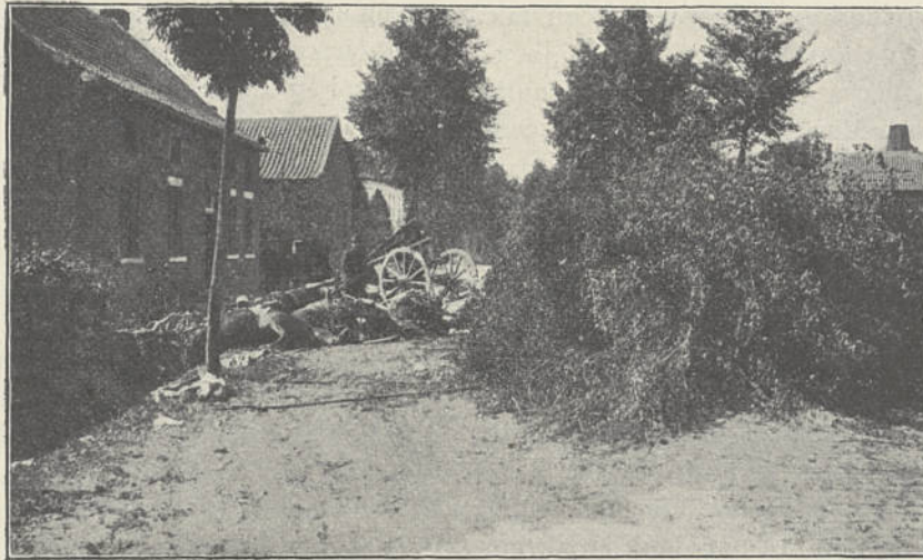
BARRAGE DANS UNE FERME A DIEST
