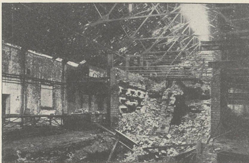
FOURS A ZINC AUX USINES DE BAELEN WEZEL
