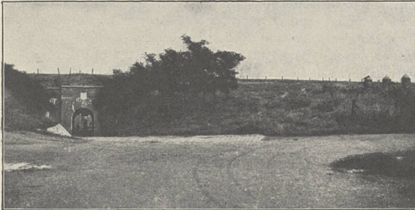
ENTRÉE DU FORT DE BARCHON
