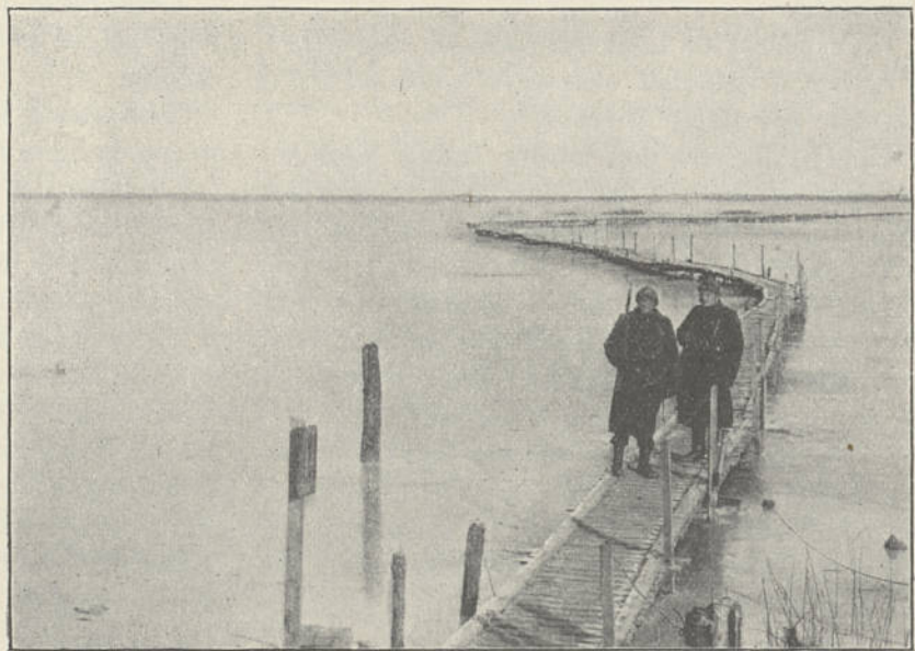
PASSERELLE DANS LES INONDATIONS DU FRONT BELGE (S. Ph. A. B.)
