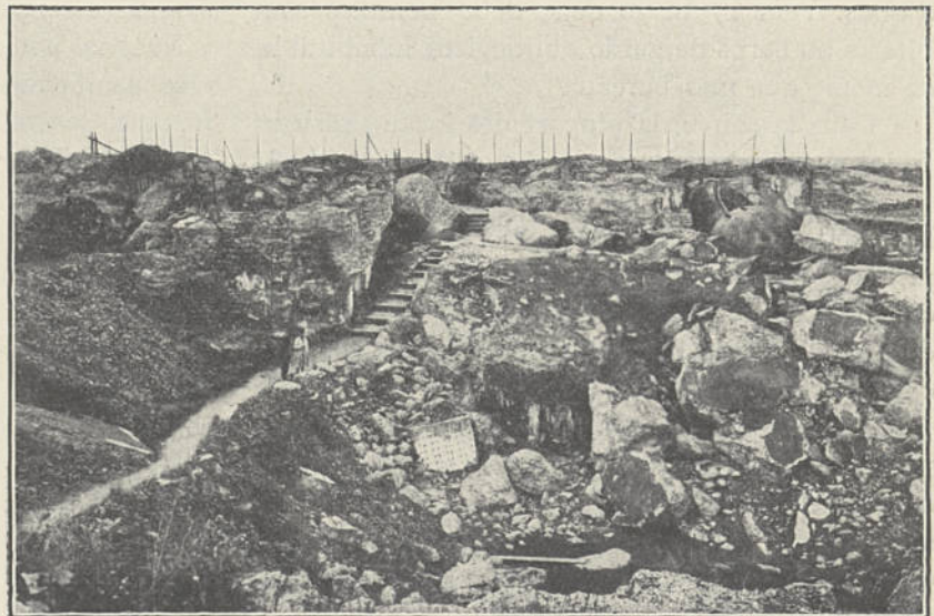
RUINES DU FORT DE LONCIN
