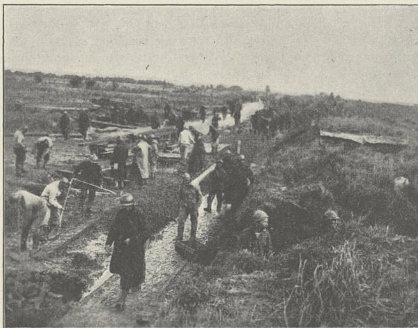
ÉTABLISSEMENT DE ROUTES ET PISTES EN BOIS POUR LA PROGRESSION DE L'OFFENSIVE
