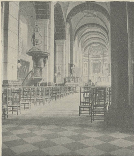
FIG. 72. INTÉRIEUR DE L'ÉGLISE DU PARC. (ÉTAT ACTUEL.)
