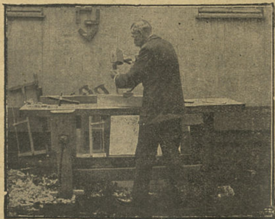
Fig. 155 bis. — Exécution d'une mortaise.
