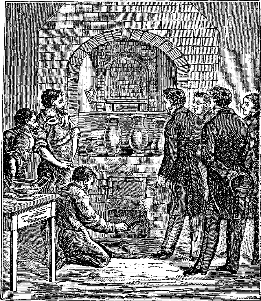
Installation du pyromètre Brongniart à la manufacture de Sèvres (page 432).
