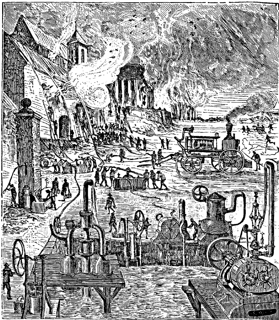
Emploi des divers systèmes de pompes dans un incendie (pages 338 et suivantes).
