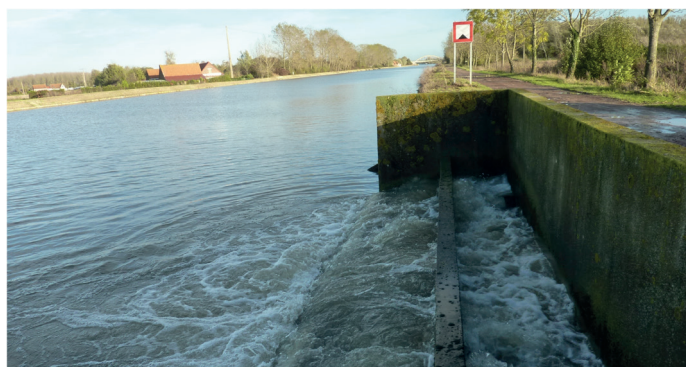
Fig. 15. – Panneau indiquant la présence d'un haut-fonds pour le passage du Grand Nocq en siphon sous le canal ; premier plan : déversement dans le canal d'un trop plein à hauteur du siphon de la Clarence à l'aide d'une vis d'Archimède. Photo © F. Meilliez.
