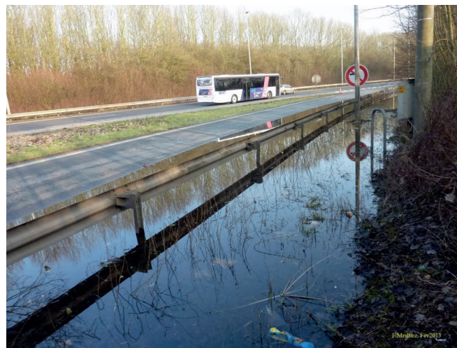
Fig. 1. – Autoroute A23 : bretelle d'accès vers Valenciennes noyée parce qu'elle est installée sur le thalweg, souvent asséché, du Ru des Voyettes (photo F. Meilliez, février 2013).
