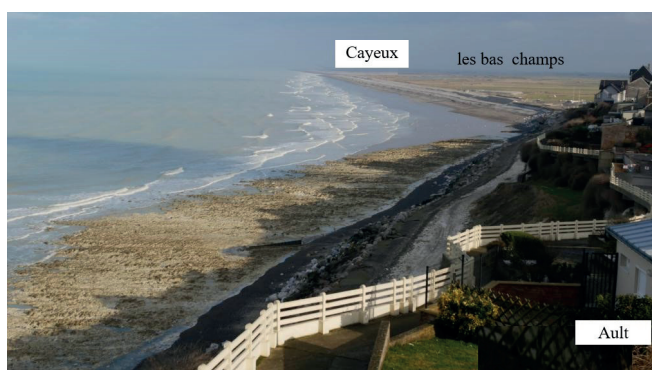
Fig. 4. – Les Bas Champs de Cayeux (Hâble d'Ault) vus du promontoire d'Ault (80). Au premier plan, on observe la falaise crayeuse (début de la côte d'Albâtre) et la « casquette », ouvrage souligné par les barrières blanches et réalisé entre 1997 et 2001 pour maintenir le trait de côte et prévenir les inondations (photo R. Duchemin).
