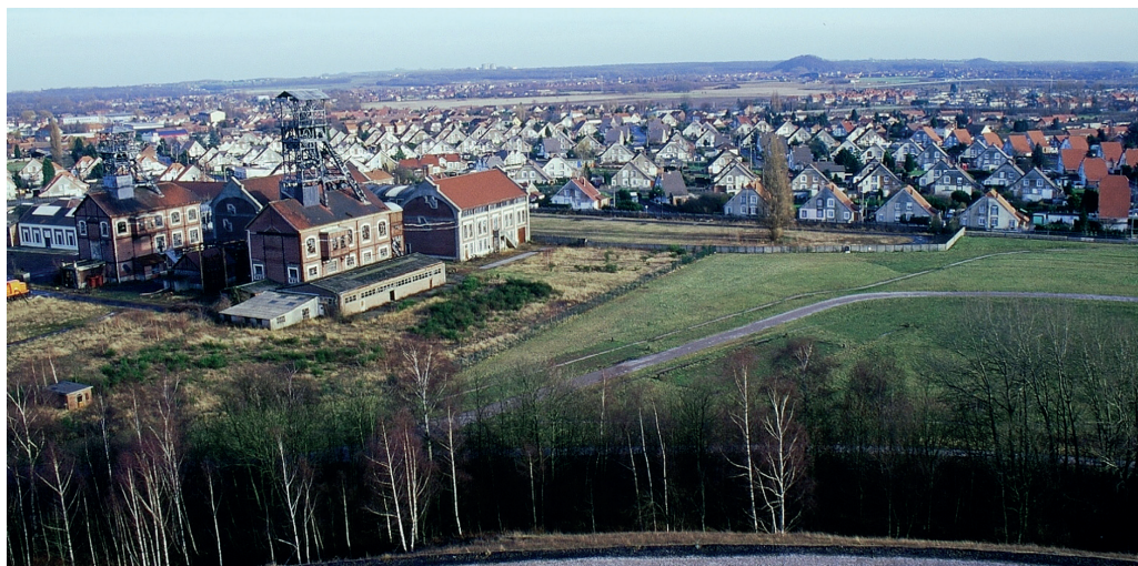
Fig. 1 – Vue sur la Fosse 9-9bis et les cités minières d'Oignies (62) depuis le sommet du terril 110. Le tout repose sur la craie du Crétacé supérieur. Au fond les tours de l'ancienne sucrerie de Thumeries, sur les dépôts sableux yprésiens qui culminent à 100 m à Mons-en-Pévèle. En second plan le terril d'Ostricourt (T108) et un peu plus loin le terril de Leforest (T122). Cliché F. Meilliez (2008).
