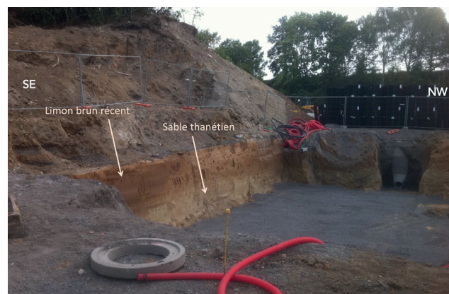
Fig. 4. – Prise de vue du point localisé sur la carte (Fig. 1) de fin 2011. Les talus terrassés (hauteur de 2 m environ) pour aménager l'accès au parking C1 destiné aux usagers du stade montrent un limon brun homogène et massif sur un ensemble vert brun qui devrait être un sable glauconieux et argileux. Le Tuffeau de Valenciennes semble absent. Photo F. Meilliez.
