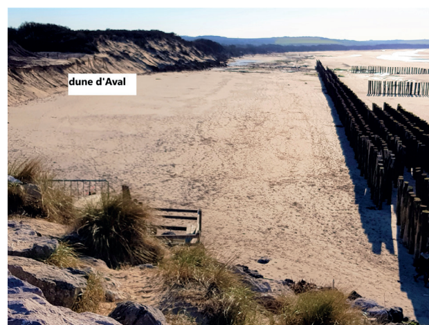
Fig. 5. – Rangée de pieux protecteurs parallèles au rivage sur la plage au bout de la digue de Wissant. Au fond, à gauche, la dune d'Aval ayant subi la tempête de 2018 (photo M. N. Rouget).
