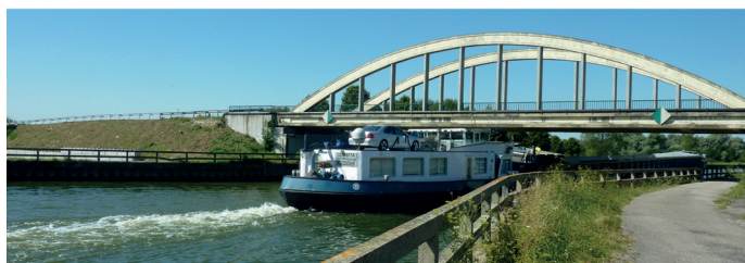
Fig. 14. – Le canal à grand gabarit à Robecq : vers l'ouest, le pont de l'Éclème devra être relevé pour accepter des barges à 2 lits de containers. Photo © F. Meilliez.
