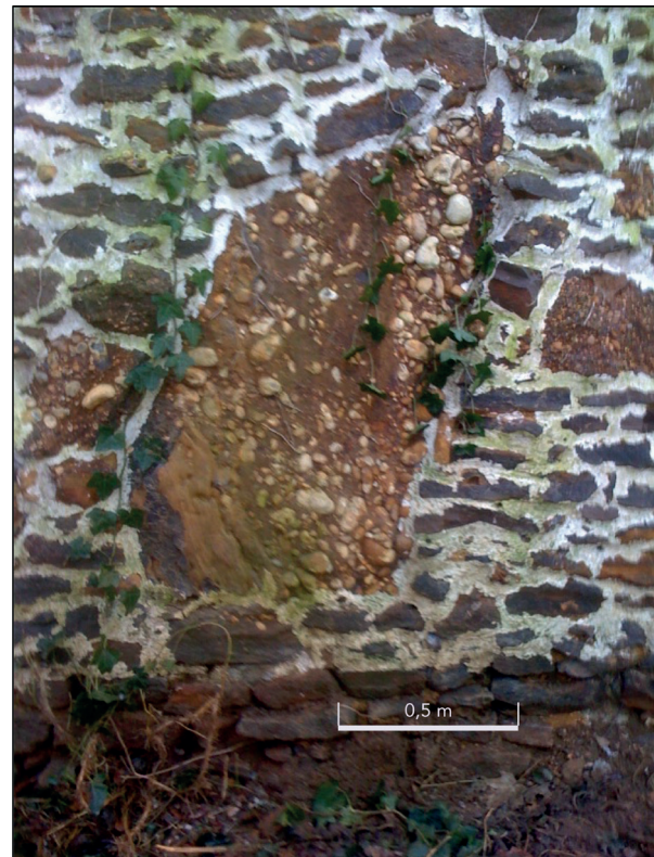
Fig. 9. – Site du Mont Noir (arrêt 1). N.-D. de la Salette. Mur extérieur de la petite maison construit avec des grès ferrugineux dont certains sont conglomératiques. © F. Meilliez (2012). Fig. 9. – Mont Noir site (stop 1). N.-D. de la Salette. External wall of the small house that have been built with ferruginous conglomeratic brown sandstones. © F. Meilliez (2012).
