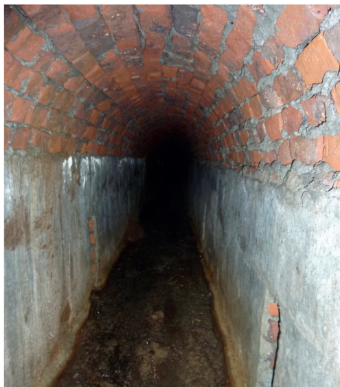
Fig. 8. – Tunnel briqueté dans le Mont Noir ayant servi de collecteur de sources dans les niveaux sableux du Lutétien. © F. Meilliez (2012). Fig. 8. – Tunnel with a brickwork cover below the Mont Noir; long time ago it had been used as a water collector flowing from Lutetian sands. © F. Meilliez (2012).
