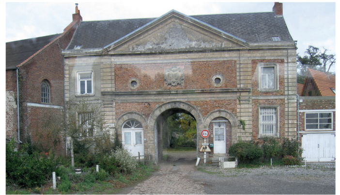
Fig. 18. – Portail d'entrée de l'ancienne abbaye de Chocques (localisée sur Fig. 17). Photo © F. Meilliez.
