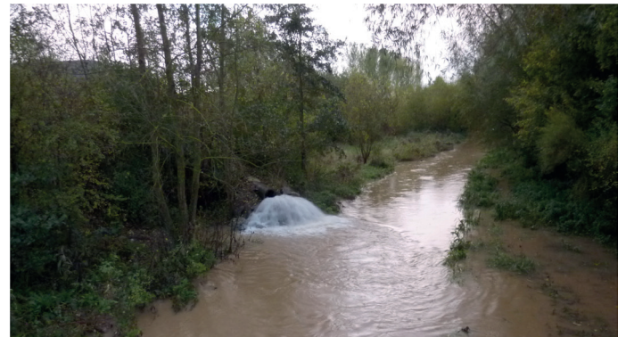
Fig. 20. – Le cours rehaussé de la Clarence à Marles-les-mines, avec la pompe de refoulement dépendant de la station de relevage des eaux située en rive droite (période pluvieuse d'octobre 2013). Photo © F. Meilliez, octobre 2013.
