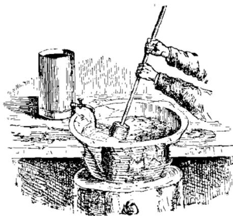
Fig. 82. Versoir et mortier pour la fabrication des émulsines.
