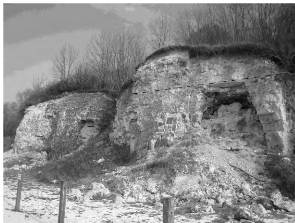
Fig. 2. — La RNR des anciennes carrières de Cléty (photo : S. Declercq/CEN, 2010) : deux fronts de taille ouvrent sur les anciennes cavités souterraines. Les tirets marquent la position du hardground hg 1, marquant la limite Turonien/Coniacien (Robaszynski et Amédéo, 2001).
