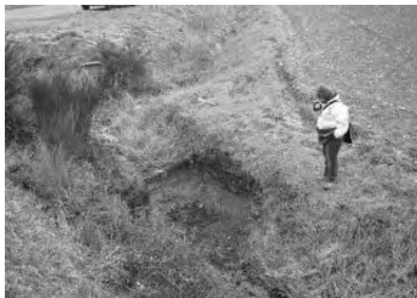
Fig. 6. — Vue de l'effondrement de décembre 2007.
