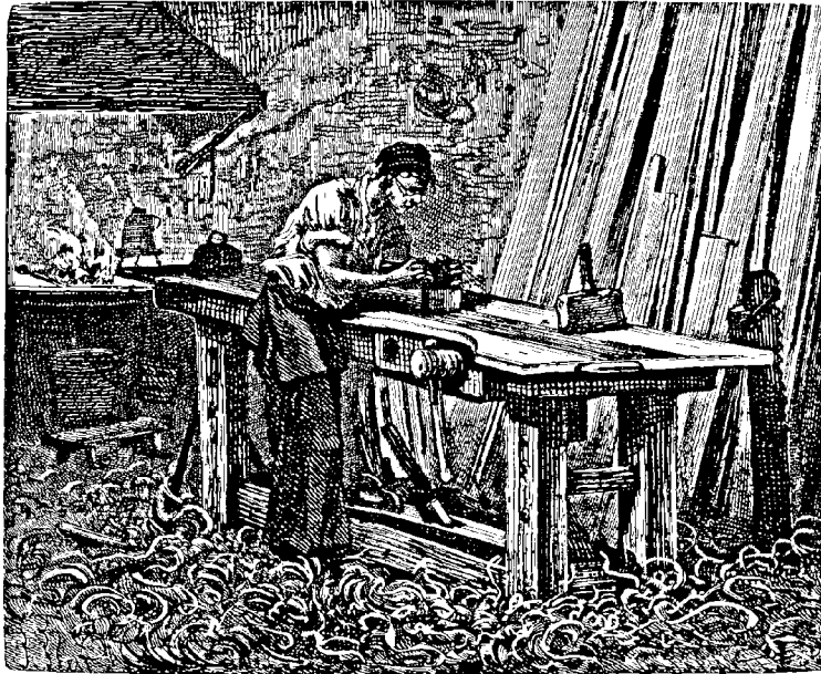
Fig. 292. — Placage au marteau.
