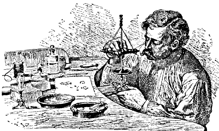
Fig. 276. — Ouvrier bijoutier manœuvrant la drille.
